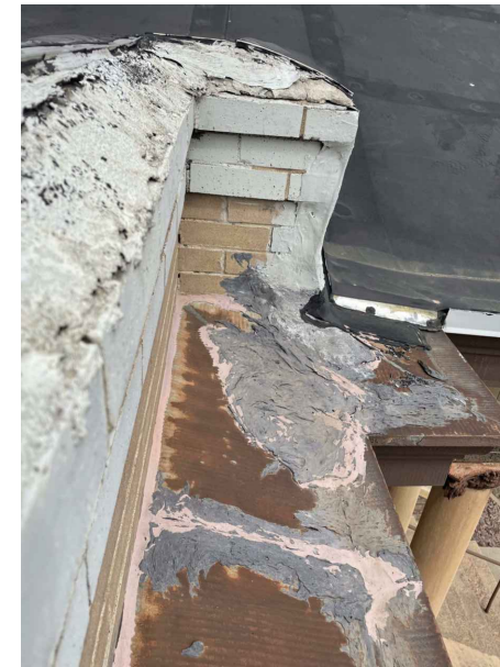
5 | EXISTING PARAPET A501 | No Scale
