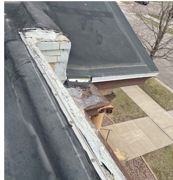
4 | EXISTING PARAPET A501 | No Scale
